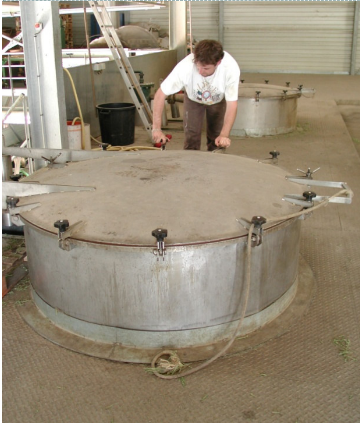
Distillerie avec cuves
